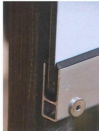
Abbildung 2: Lagerung der Aluminiumverbundplatte in einer Glasleiste
